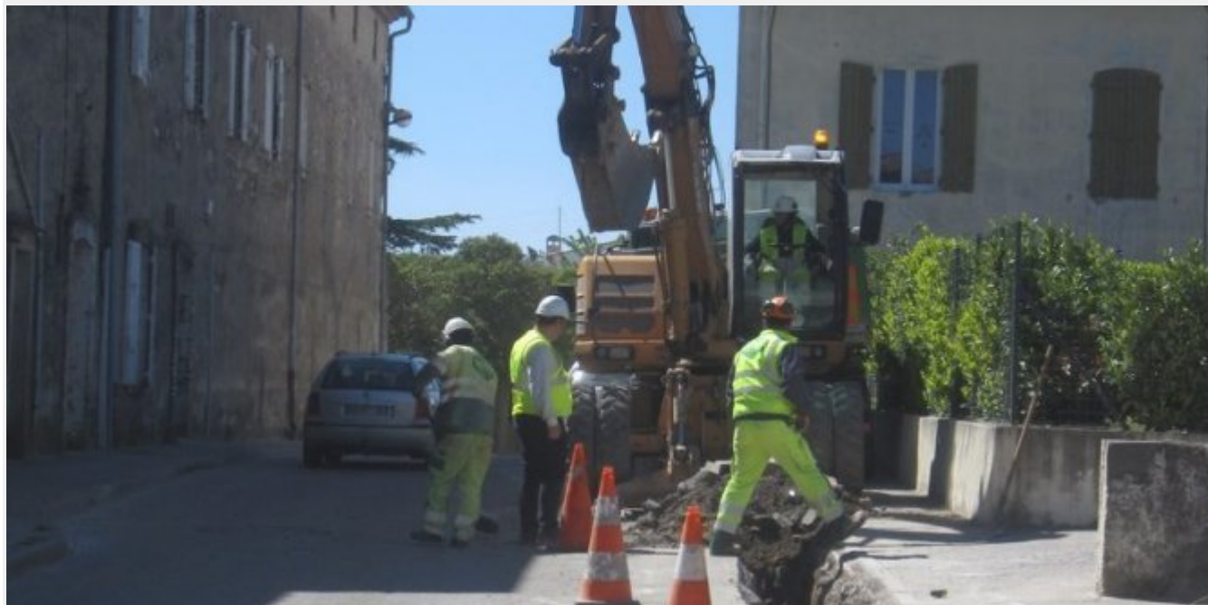
Les travaux avancent. Fernand Tailhades
